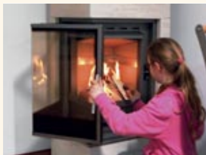
3. Holz anzünden: Anzündhilfe im oberen Drittel platzieren und in Brand setzen, Ofentür kurz anlehnen, dann schließen.
